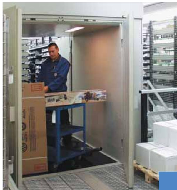
*Installazione in un concessionario di automobili (Italia), modello 1000 kg, doppio accesso con porta a due battenti.*
