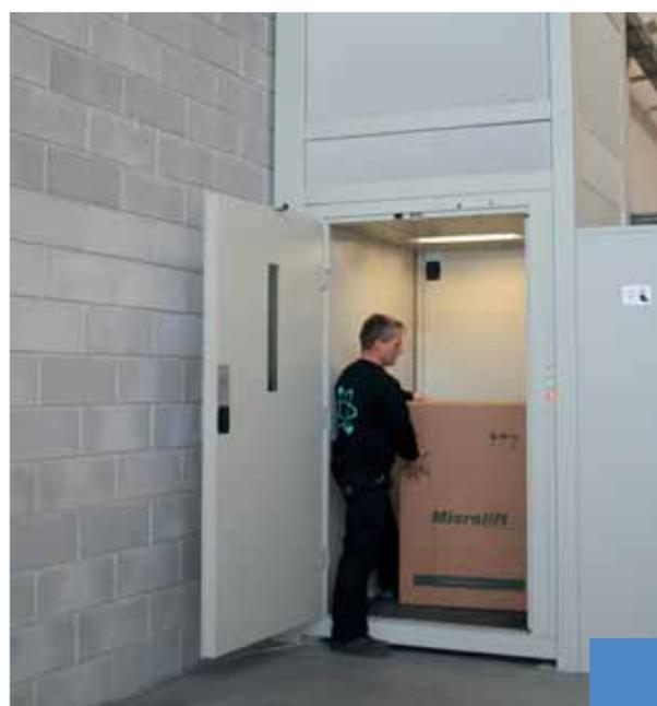
*Installazione in un magazzino (Italia), modello 500 kg, porta a singolo battente, finestra con vetro reticolato, finiture standard RAL 7038.*
