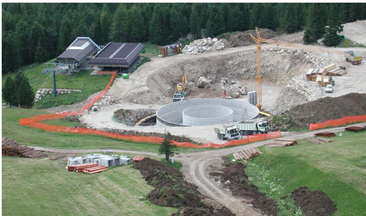
Foto 9. Realizzazione di due vasche interrate circolari per l' accumulo idrico a servizio dell'impianto di innevamento programmato nella ski area del Belvedere - Canazei (TN).
