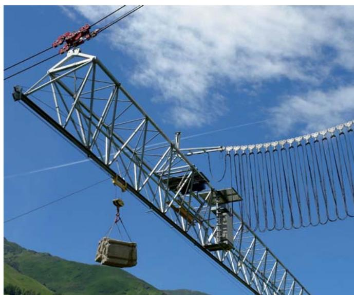
Foto 14. Impianto speciale a carro ponte su funi installato nel comune di Garzeno (CO) per la bonifica di un versante in frana.
