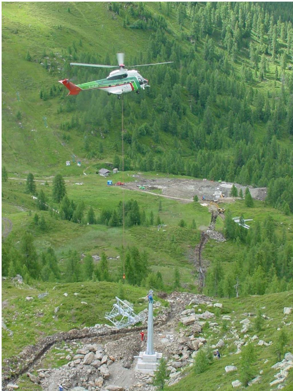
Foto 7. Montaggio con elicottero della linea della seggiovia quadri-posto ammortamento automatico "Malga Tognola - Rododendro" presso San Martino di Castrozza (TN).
