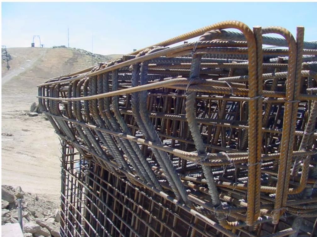
Foto 2. Armatura in acciaio delle stive della stazione motrice della seggiovia quadriposto ammortamento automatico "Malga Tognola - Rododendro" – San Martino di Castrozza (TN).
