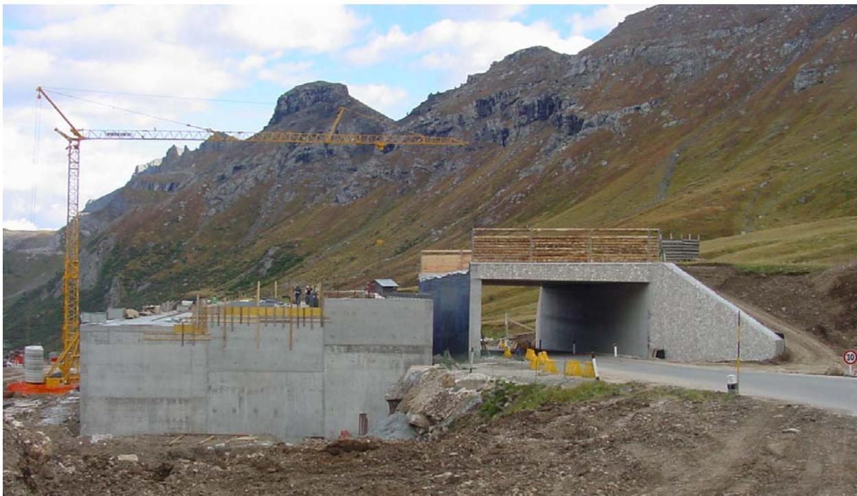
Foto 10: Realizzazione di due bacini di accumulo idrico per innevamento artificiale da circa 7.000m<sup>3</sup> cadauno e di un sovrappasso sciistico nella ski area di "Arabba - Pordoi" (BL).
