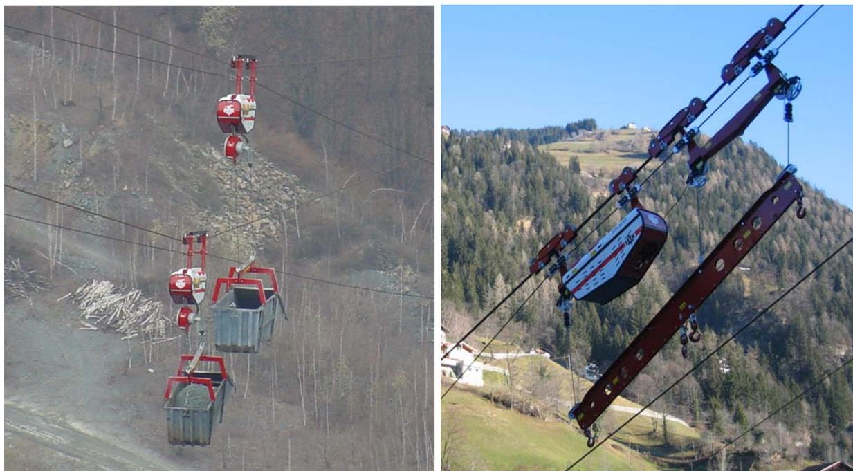
Foto 12. Sinistra: teleferica installata per la bonifica di un versante nel comune di Balangero (TO).
