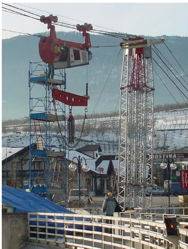
Foto 12. A sinistra: teleferica ad anello chiuso per il montaggio del Funifor "Tarlenta - ex Rif. Mantova" - Pejo (TN).
