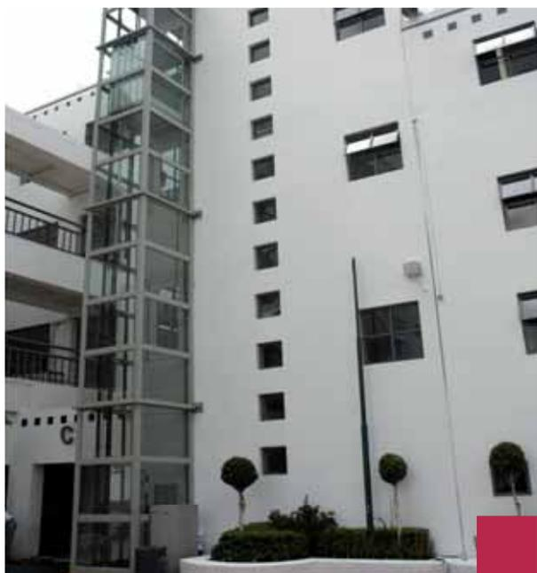
*Installazione esterna in un condominio (Messico), struttura con rivestimento in vetro. La struttura portante permette l'installazione anche in assenza di un apposito vano.*
