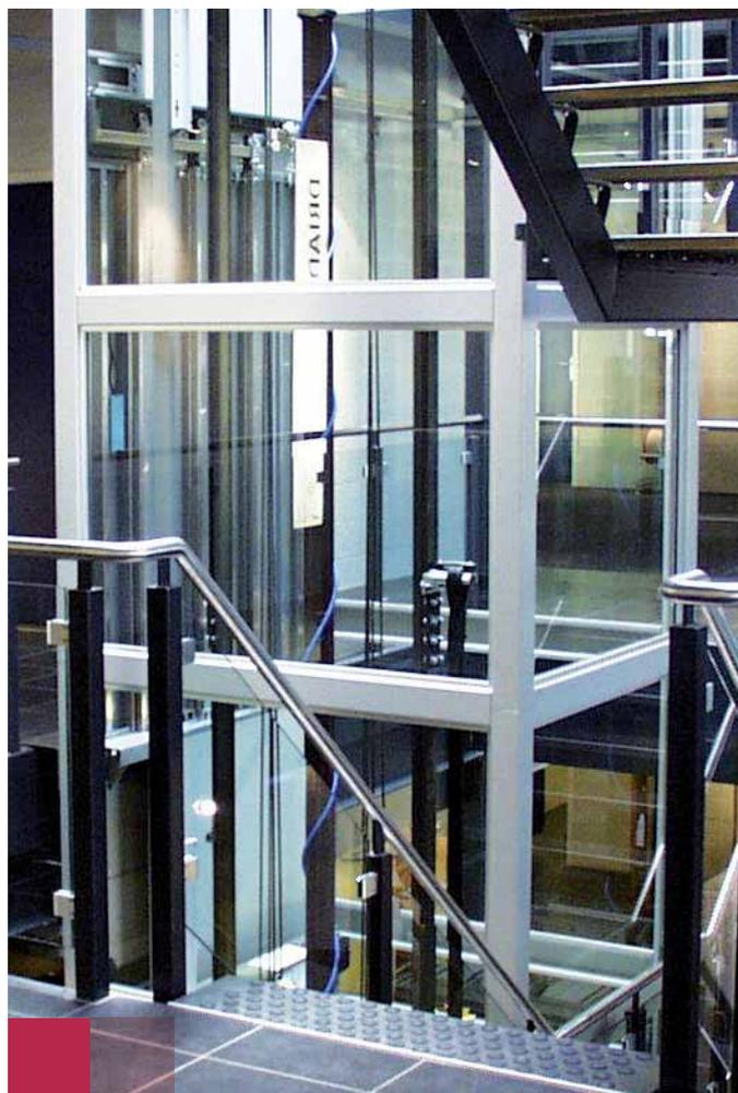
*Installazione con struttura portante in un'azienda (Olanda), finiture in lamiera e rivestimento in vetro.*
