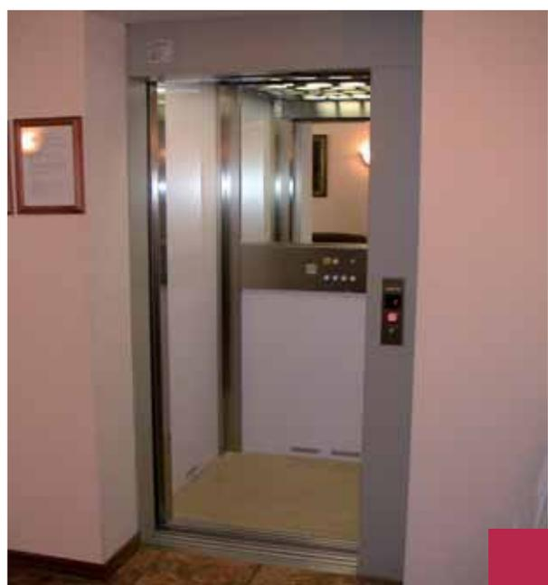
*Installazione in un hotel (Russia), rivestimento cabina in lamiera plastificata, pulsantiera e profili cabina in acciaio inox, specchio mezza parete.*
