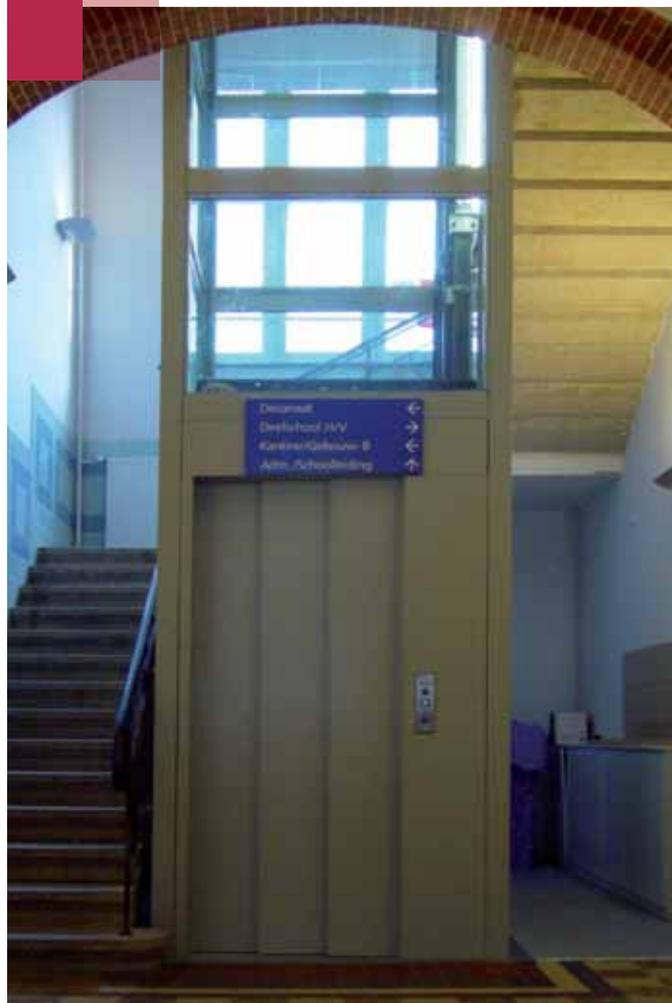
*Installazione in un edificio pubblico (Italia), struttura in acciaio inox con rivestimento in vetro, cabina con parete panoramica, porta automatica a due battenti, finiture pareti cabina in lamiera plastificata bianca.*
