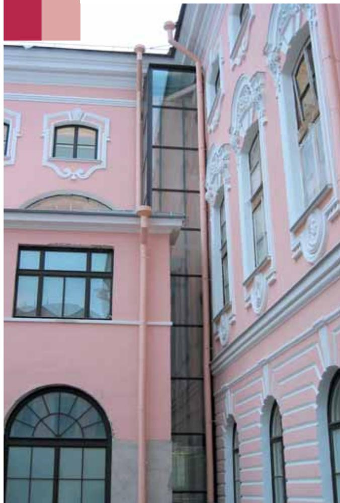
*Installazione in un condominio (Italia), struttura portante per interni in acciaio inox con rivestimenti in vetro, cabina con parete panoramica e finiture in acciaio inox. L'ascensore è stato installato nello spazio ricavato nel vano scala, senza bisogno di muri portanti.*
