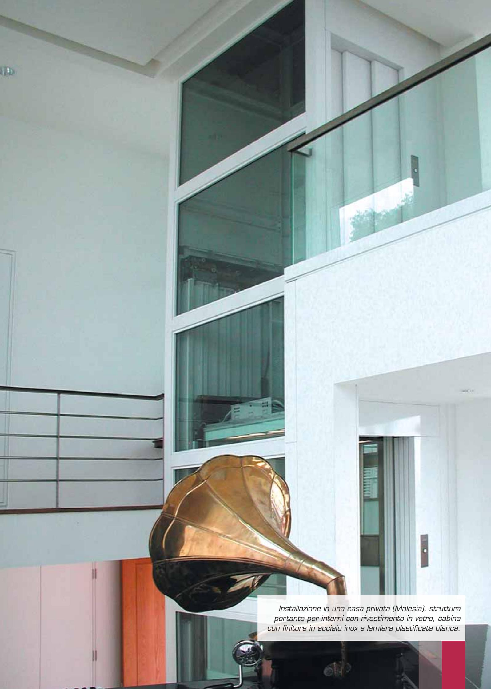
*Installazione in una casa privata (Malesia), struttura portante per interni con rivestimento in vetro, cabina con finiture in acciaio inox e lamiera plastificata bianca.*
