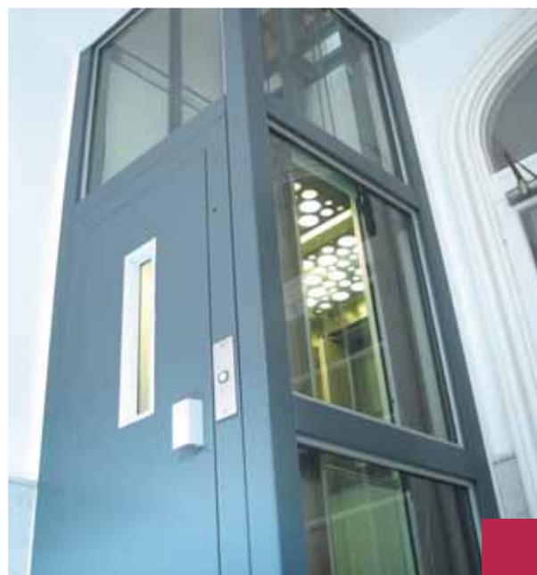
*Installazione in una casa privata (Olanda), struttura portante installata all'interno dell'edificio, rivestimento in vetro, cabina con parete panoramica e porta a battente.*
